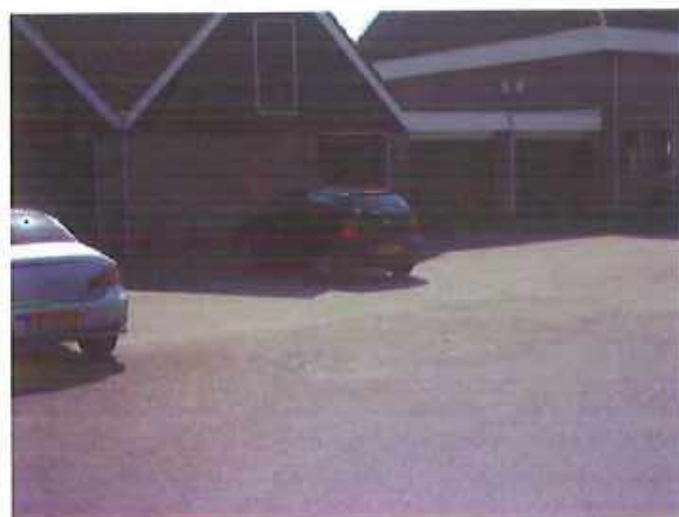
Foto 3: Voormalige ondergrondse tank
