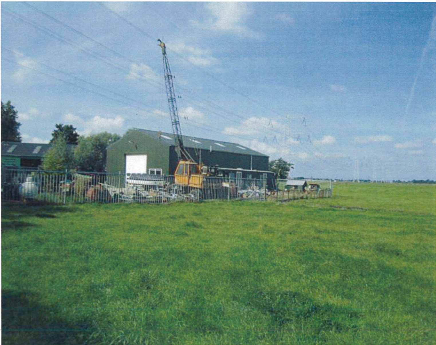
Foto 11. De nieuw gebouwde loods.
