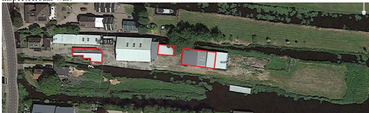
niet toegankelijk of inspecteerbaar vanwege opslag materialen
