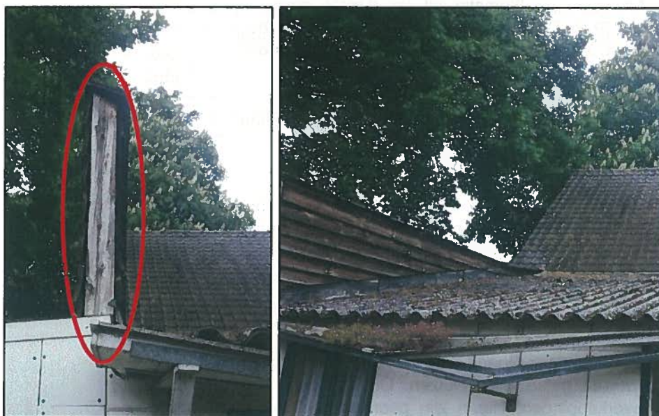
Afbeelding 5: Houten betimmering met mogelijke invliegopeningen (rode cirkel), zowel van de kopse kant gefotografeerd (links) als van de zijkant (rechts).
