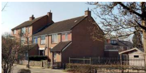
Afbeelding: bebouwing aan de Amer zijde schoolgebouw
