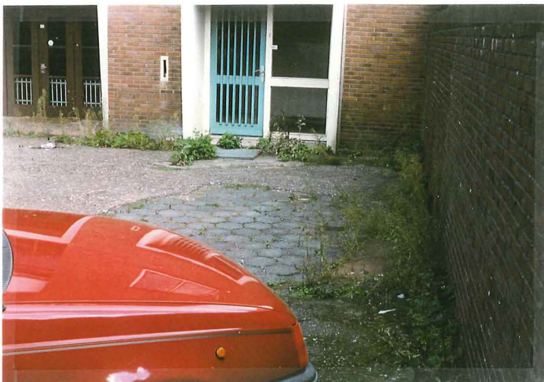
Zijde Ceintuurbaan; ligplaats van voormalige ondergrondse tank (betonklinkers in asfalt)
