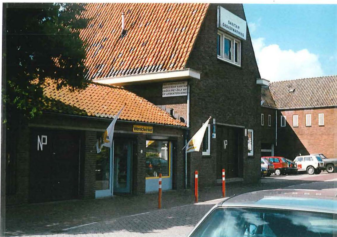
Zijde Keucheniusstraat met belendend perceel (wereldwinkel en loodgietersbedrijf).
