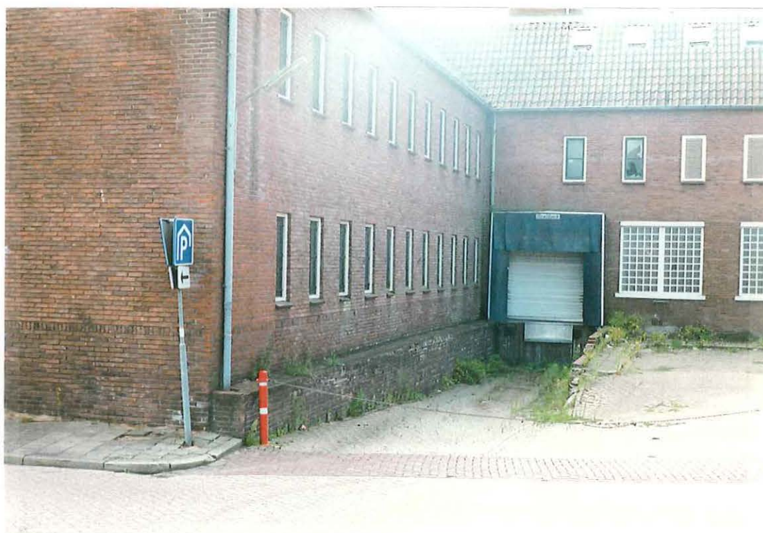
Zijde Keucheniusstraat; het noordelijke laad-platform (let op verdiepte aanleg)
