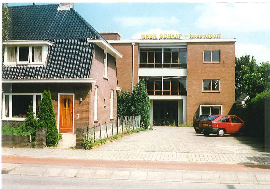
Zijde Ceintuurbaan 7; de ingang van het kantoor van het kaaspakhuis
