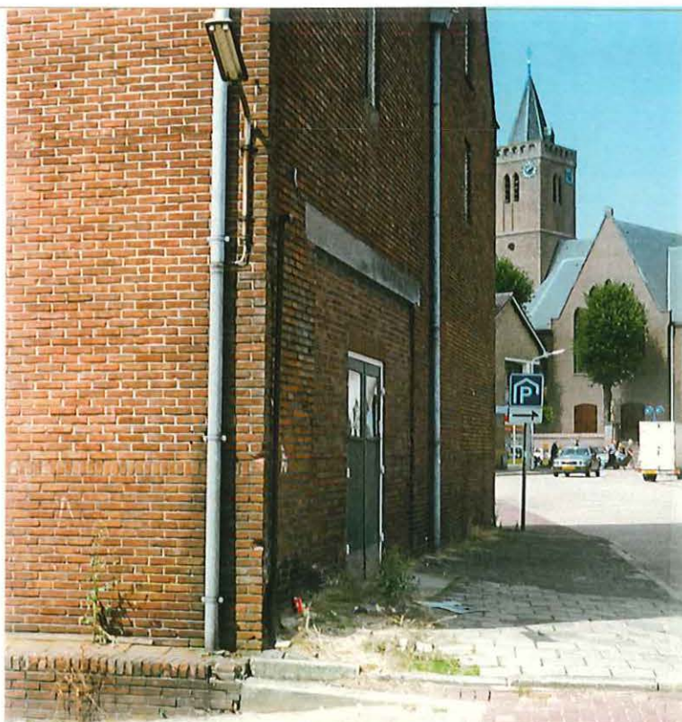
Zijde Keucheniusstraat; ontluchtspijp van ondergrondse tank
