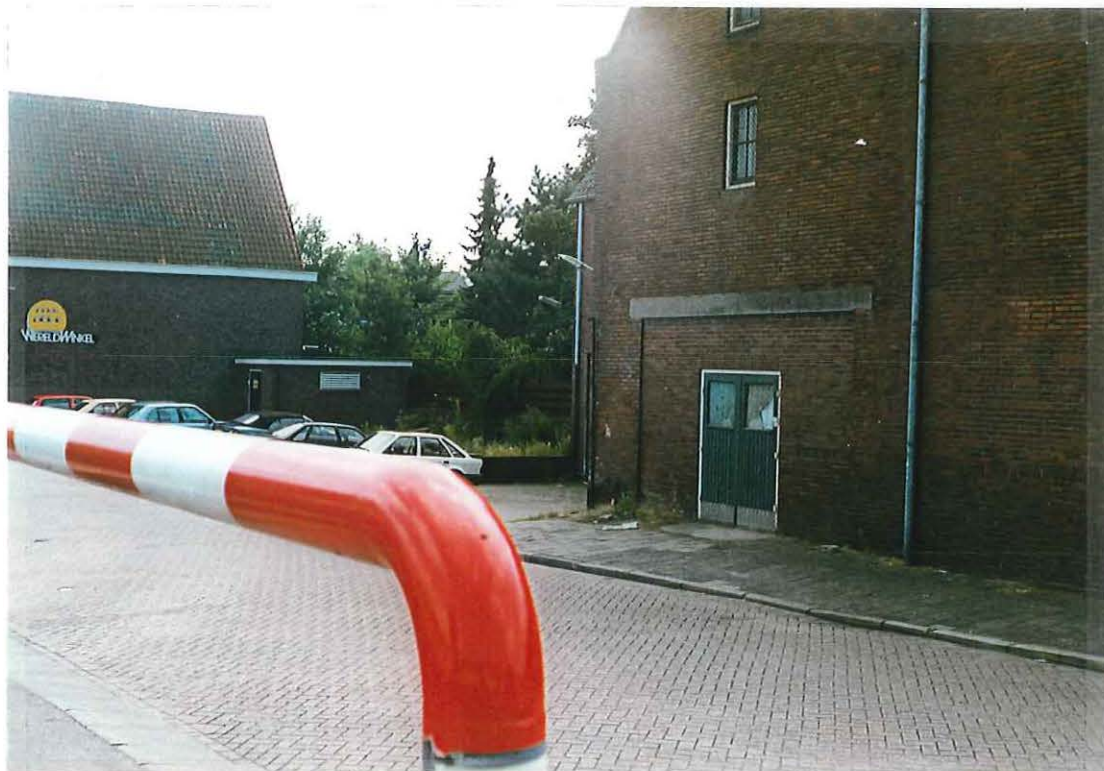
Zijde Keucheniusstraat, ingang van voormalige garage (dichtgezette ingang) en ontluuchtingspijp van olietank (op hoek van voormalige garage).
