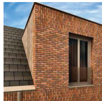
Dakkapel gemetseld uitgevoerd
