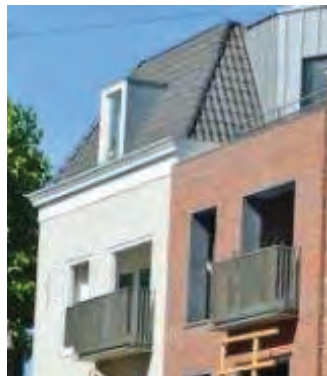
Loggia + uitkragend balkon
