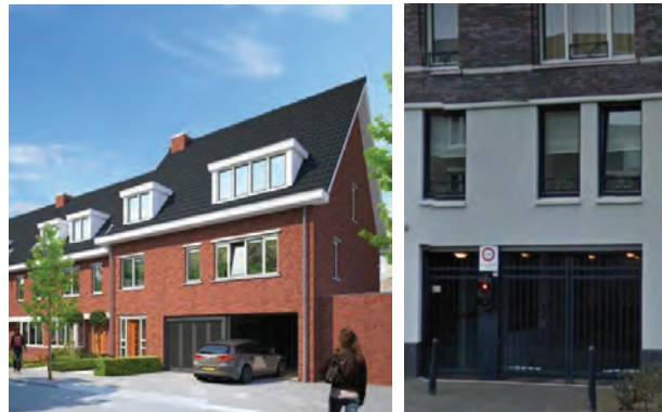
Afbeelding: entree parkeergarage
