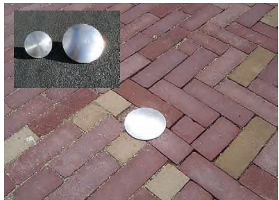
RVS markeringen (terras, uitstalzone)
