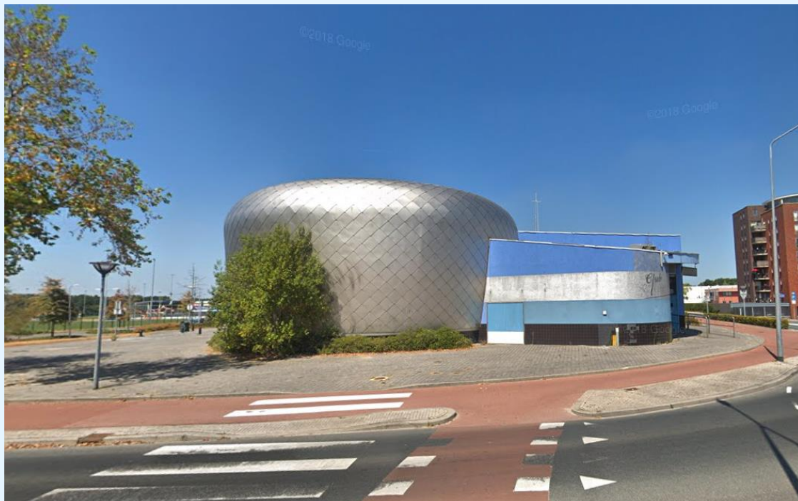
figuur 5: te slopen bestaand pand (bron: Google Streetview)
