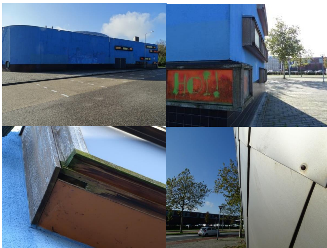
Impressie van het projectgebied (16 oktober 2019) met de discotheek (foto 1 en 2), de houten sierbetimmering (foto 3) en de metalen muur- en dakbedekking van de westelijke koepel van het pand (4).
