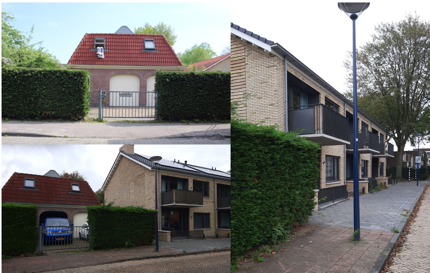
figuur 2.2 dubbele garage aan de Pater Bleijsstraat
