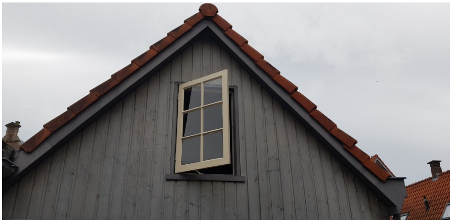
afb.25 Nokvorsten en kantpannen in tact, geen invliegopeningen
