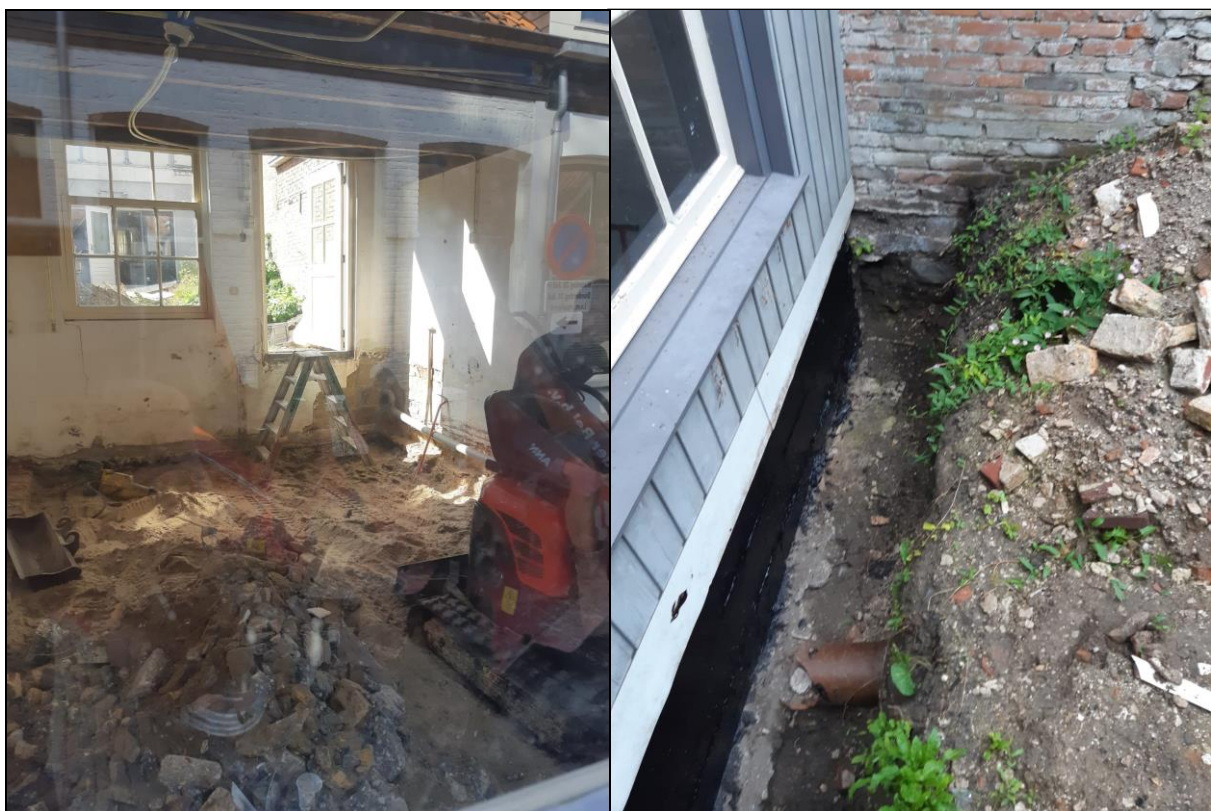
Afbeelding 2. De reeds uitgevoerde werkzaamheden in de berging aan de Trommelstraat (foto's AWF, 22-07-2021 & 19-08-2021).
