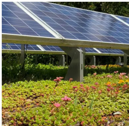
Zonnepanelen in combinatie met een groen dak
