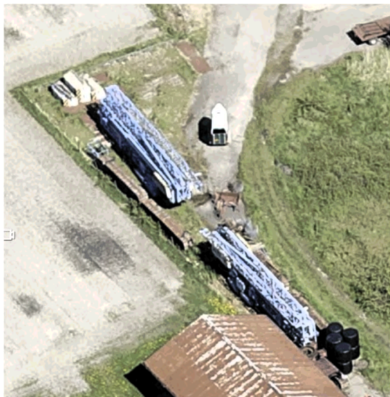
Figuur 3.1 Luchtfoto noordelijk deel met opslag machines
