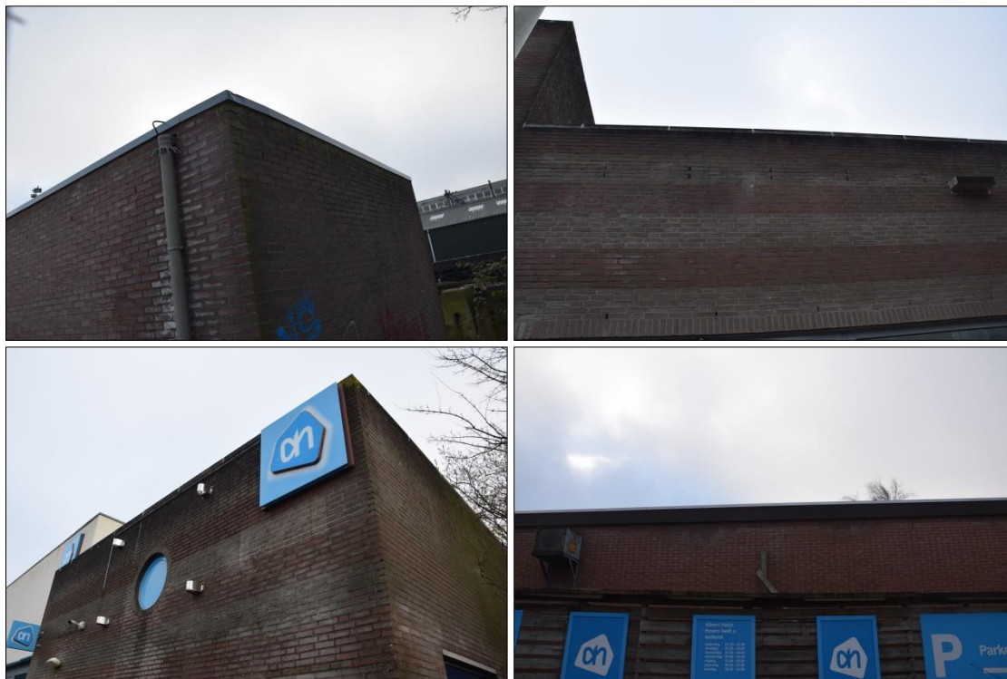
Foto's 3 - 6. Impressie van de drie gebouwen met open stootvoegen. Linksboven het trafogebouw, rechtsboven en linksonder de Albert Heijn en rechtsonder het bijgebouw van de Albert Heijn.
