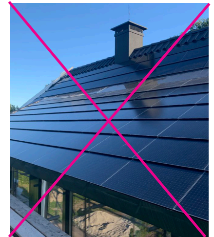
gehele dakbedekking van zonnepanelen
