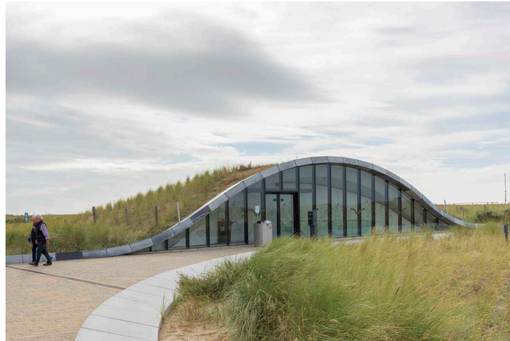
entree parkeergebouw in Katwijk
