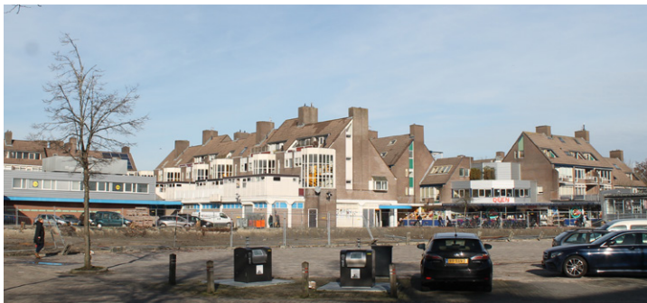
Situatiebeeld vanaf het zuiden
