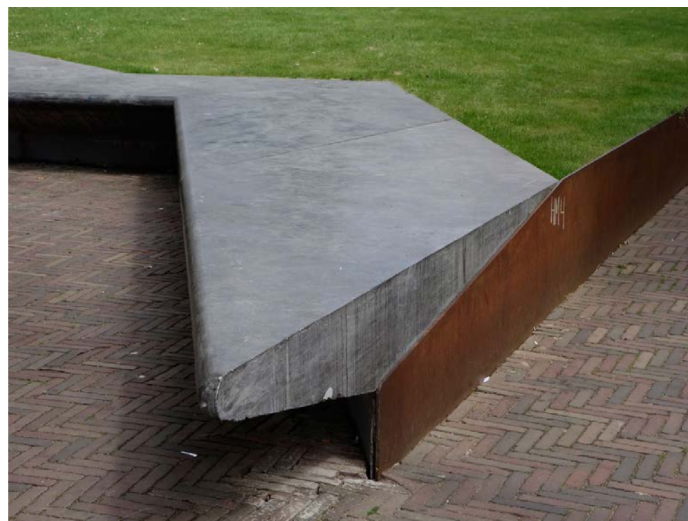
Alternatief: hoekdetail in overgang van keerwand naar daktuin/looppad
