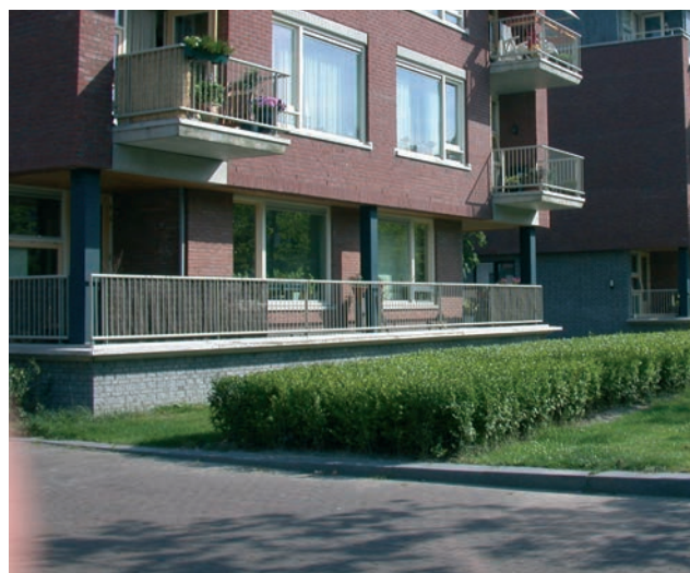
Buitenruimte opgetild ten opzichte van het straatniveau
