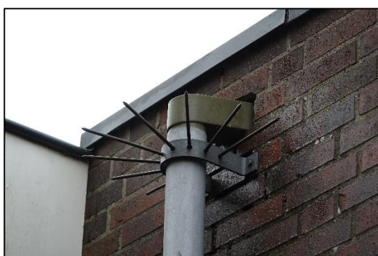
Figuur 13: Openingen bij regenpijpen die zijn afgeschermd met metalen pinnen.
