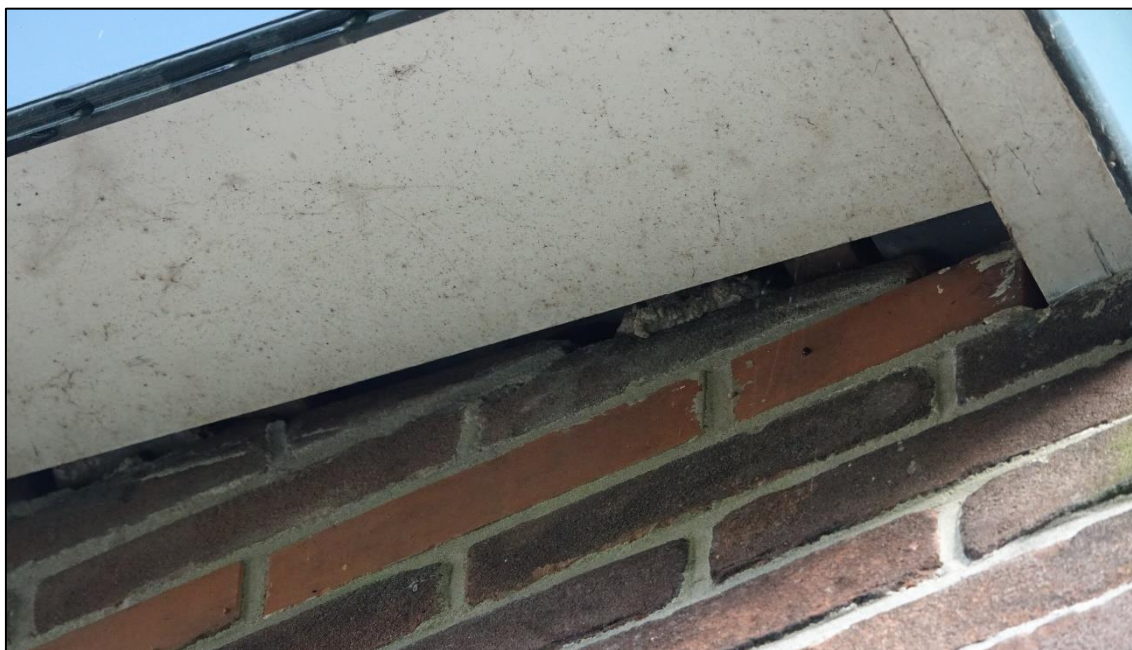
Figuur 18: Ruimte tussen de dak en voorgevelafwerking aan de Holenweg 10
