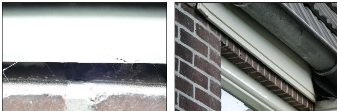
Figuur 19: Ruimte tussen de zijgevel afwerking gevuld met spinnenrag..
