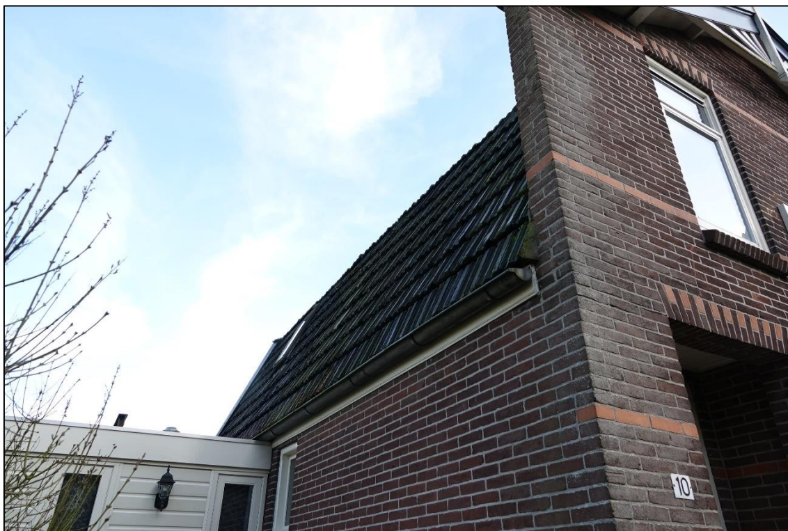
Figuur 17: Opstal aan de Holenweg 10 zonder open stootvoegen en rechte dakpannen.
