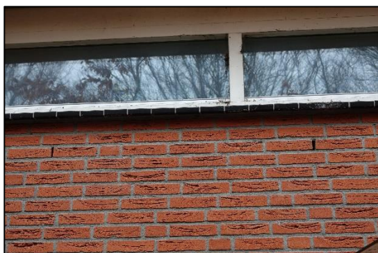
Figuur 14: Foto impressie van verschillende open stootvoegen.
