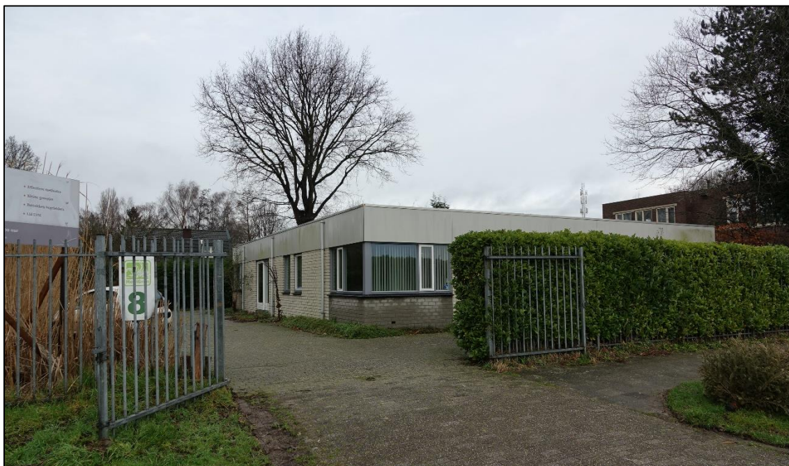
Figuur 6: Opstal aan de Holenweg 8.
