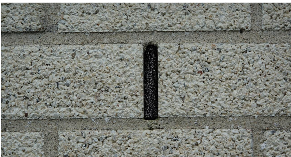
Figuur 16: Openstootvoeg in het opstal aan de Holenweg 8 gevuld met gaas.
