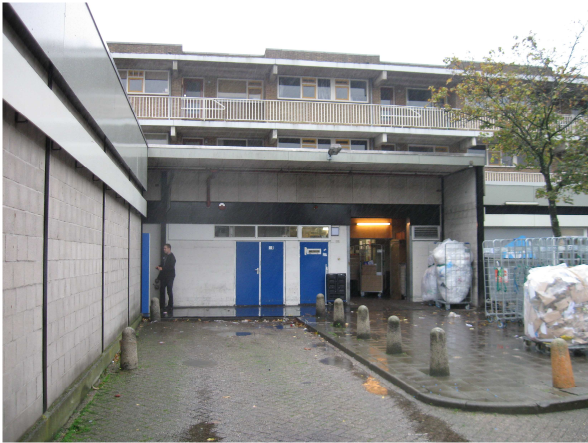
Figuur I.2 Bestaande laad- en loslocatie
