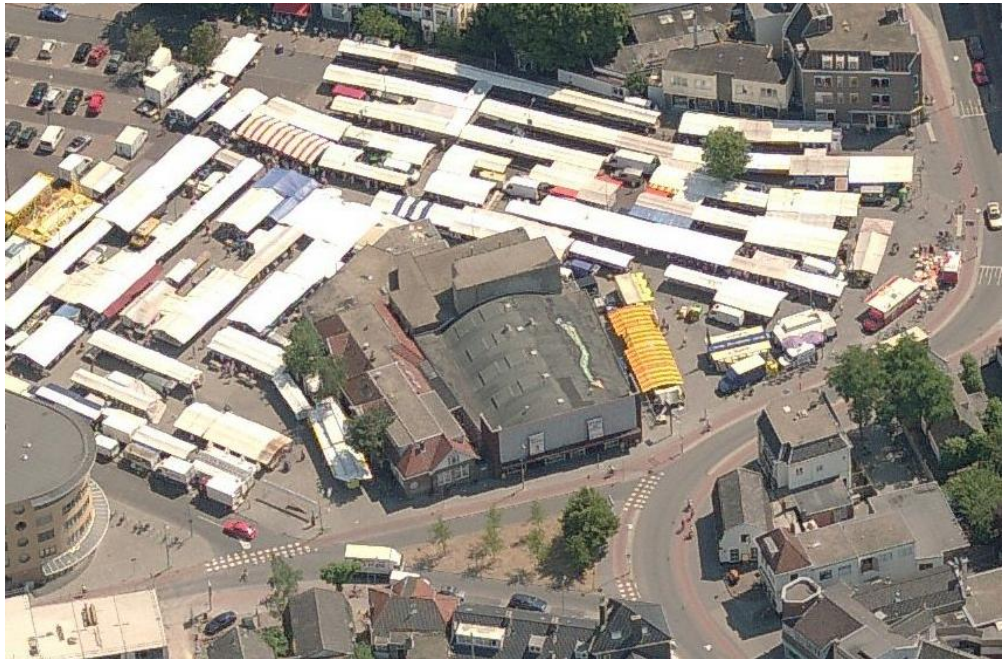
Figuur 1: Luchtfoto Naarderstraat 8 (linker aanbouw is gesloopt in 2013/2014)
