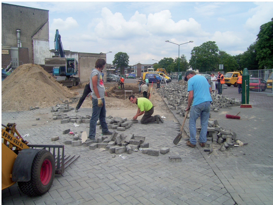
Afb. 3 Dichtgooien, aantrillen en bestraten van gedocumenteerde delen van werkput 5. Ergens middenin wordt de werkput archeologisch gedocumenteerd.
