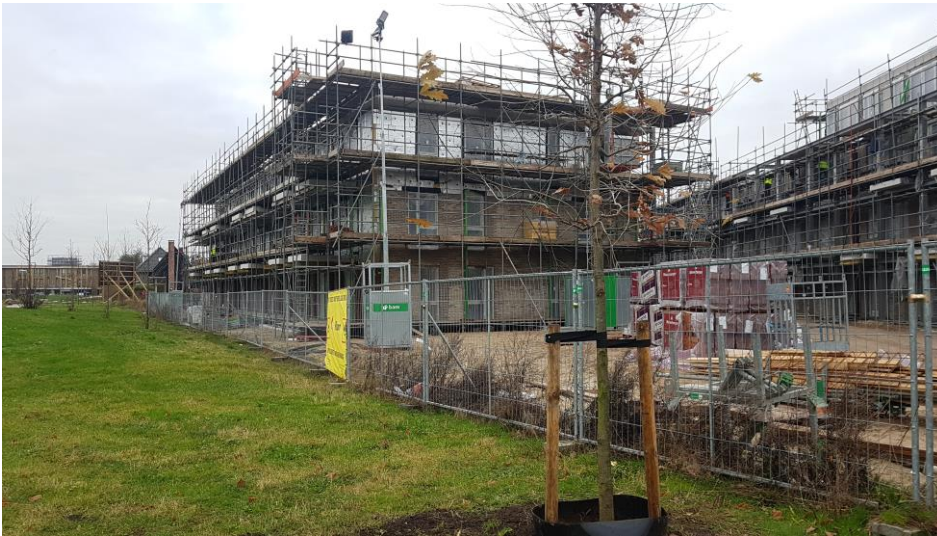
Figuur 1.6 Bouwplaats boven het Klaas van Beeckpad.
