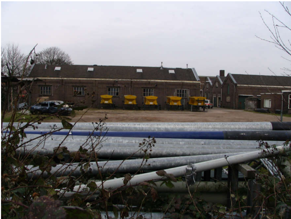
Foto 2 – Open terrein zuidwestzijde, gevel gebouw 3
