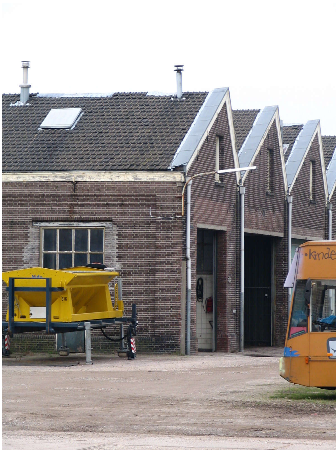
Foto 5 – Gevel gebouw 3, zuidzijde
