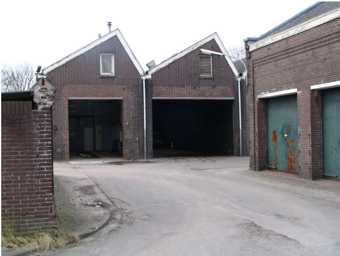
Foto 10 - Gebouw wasplaats, gebouw 3
