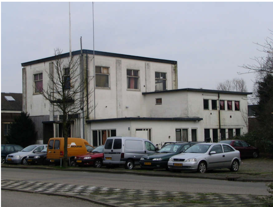
Foto 3 – Gebouw 8: Bedrijfswoning/kantoor (gekraakt)
