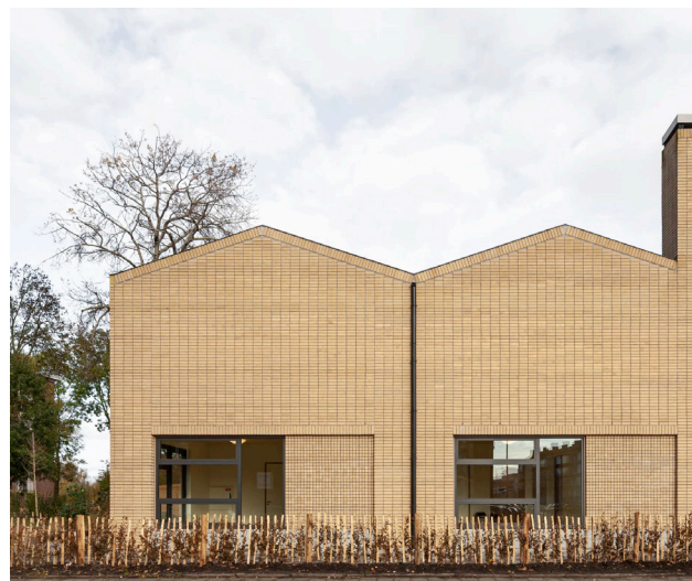
Ritmiek in de gevels en in de materialisering.
