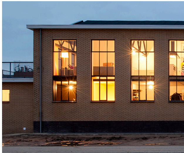
Clustering van ramen tot grote industrieel achtige openingen in de gevelvlakken.
