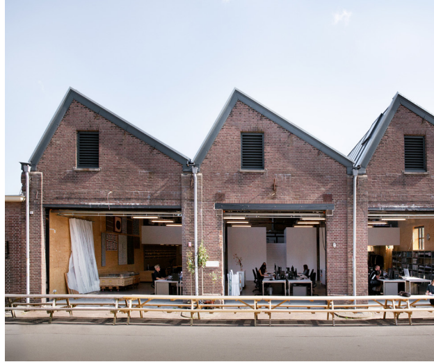
Ritmiek van dakkappen en gevelopeningen tot aan het maaiveld.
