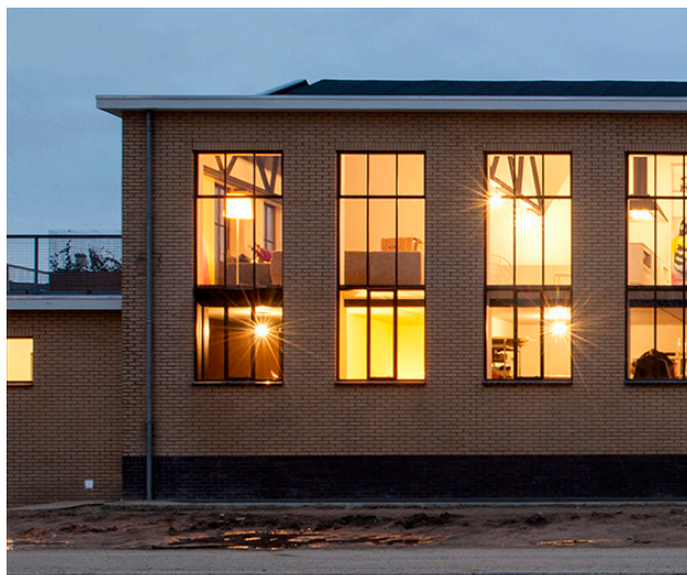
Ramen komen niet tot aan het maaiveld.
