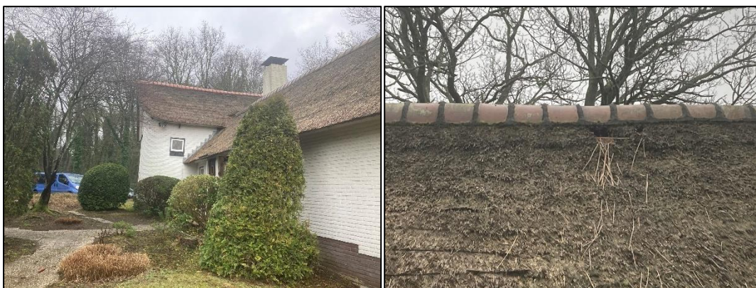
Figuur 1.7 (links): Aanzicht van de noordwestelijke zijde van het zuidelijk gelegen gebouw; Figuur 1.8 (rechts): Sporen van vogels die gebruik maken van de rieten dakbedekking.
