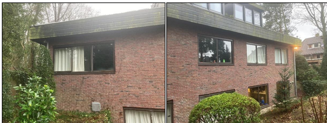
Figuur 2.7 (links): De achterzijde; Figuur 2.8 (rechts): De aflopende grond waardoor je vanuit de kelder naar buiten kunt kijken. .
