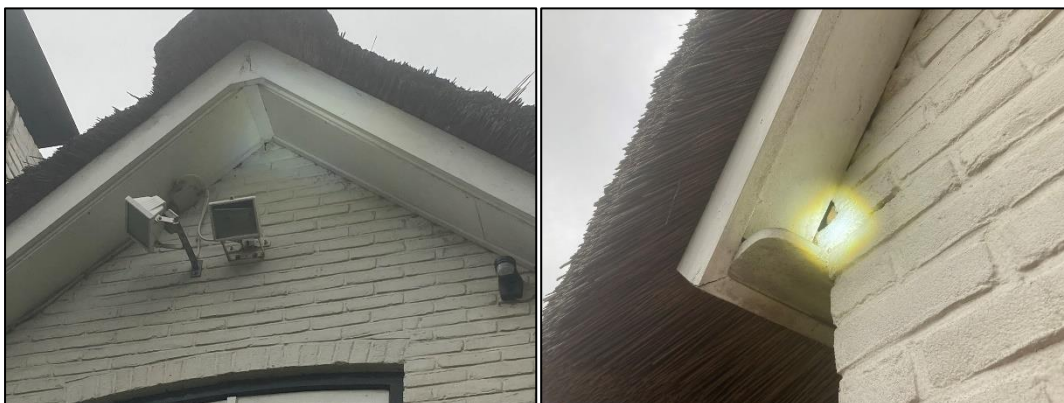
Figuur 6.5 (links) en 6.6 (rechts): Het gebouw aan de zuidzijde van het perceel vertoont voornamelijk rond de daklijst meerdere openingen met potentie voor een vleermuisverblijf.
