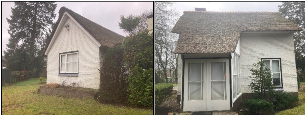
Figuur 2.18 (links): De achterzijde; Figuur 2.19 (rechts): De voorgevel van het gebouw.
