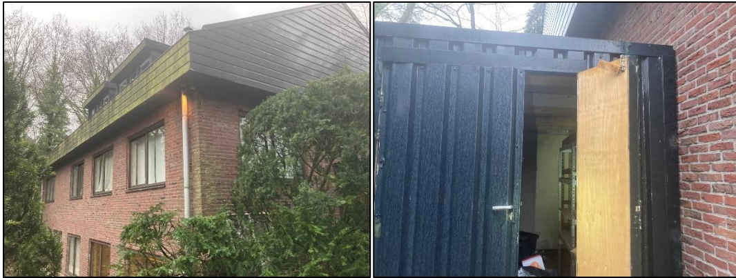
Figuur 2.9 (links): De achter- en linkerzijde; Figuur 2.10 (rechts): De metalen schuur aan de linkerzijde van het gebouw.
