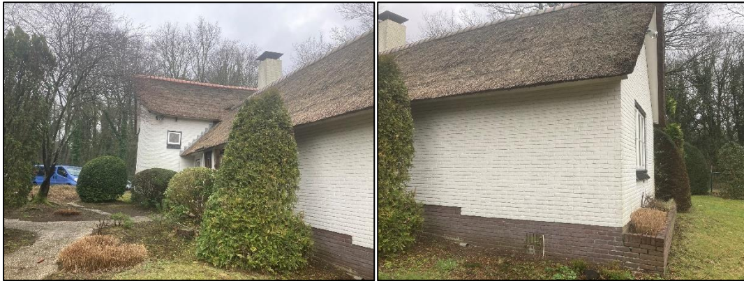
Figuur 2.16 (links): De tuin rondom het gebouw; Figuur 2.17 (rechts): De zuidwestzijde van het gebouw.
