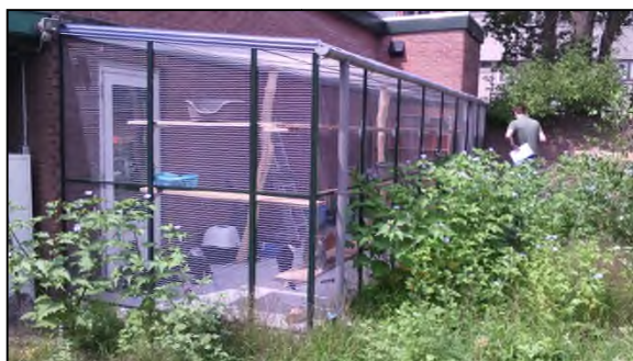
Foto 3.3: Buitenverblijf gaas (wanden) en met afdekking (dak)
