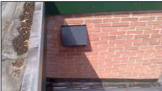
Afbeelding 3.8 Rooster WTW-unit
