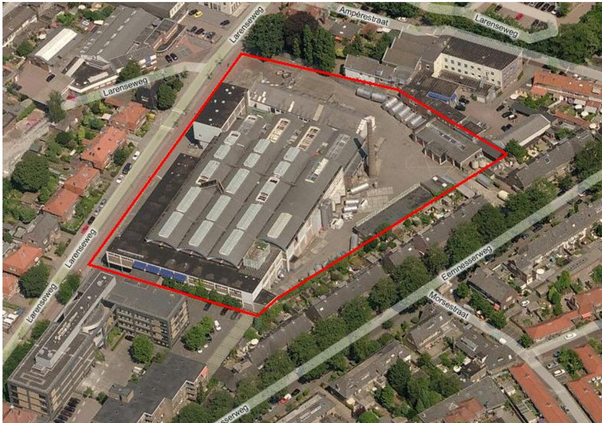
Fig. 2: Bestaande situatie van het plangebied. Bron: maps.msn.nl/
