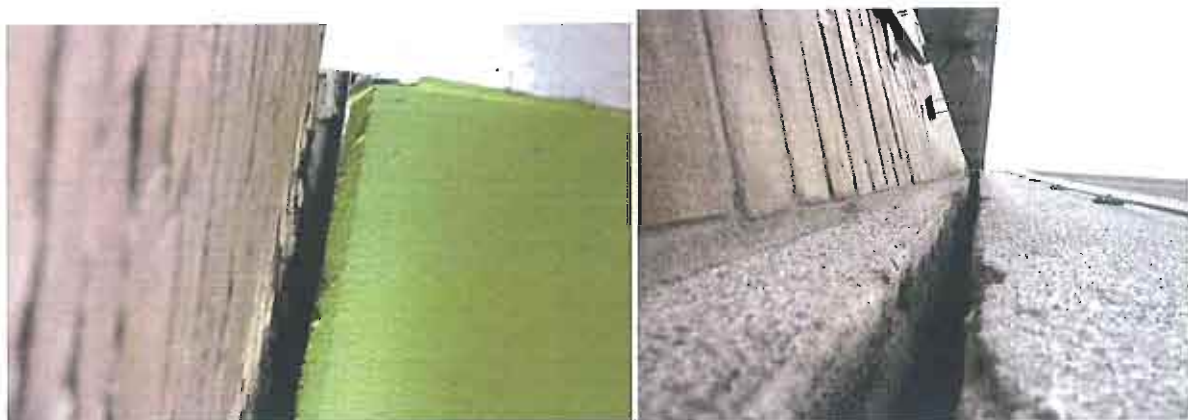
Fig. 5: Kieren aan buitenzijde van het pand aan de Larenseweg 34.
