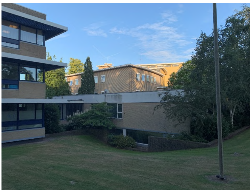
Figuur 2: Links het bestaande gebouw en rechts het gesloopte gebouw met in het midden het verbindingsstuk gezien vanaf de 's-Gravelandseweg ten westen(gefotograaf richting het zuidoosten).
