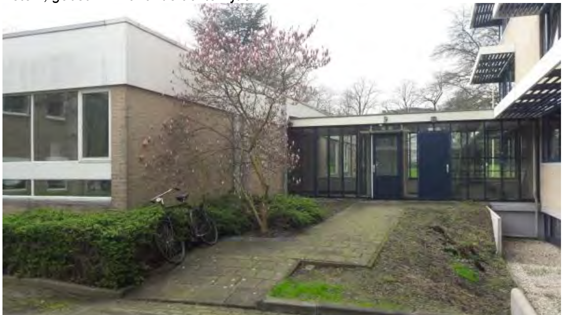
Foto 2, gebouw A vanaf de achterzijde
