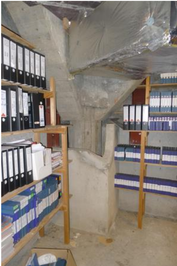
Detail van de betonnen constructie op de tussenverdieping onder de oude jazzband-studio (studio 2).
