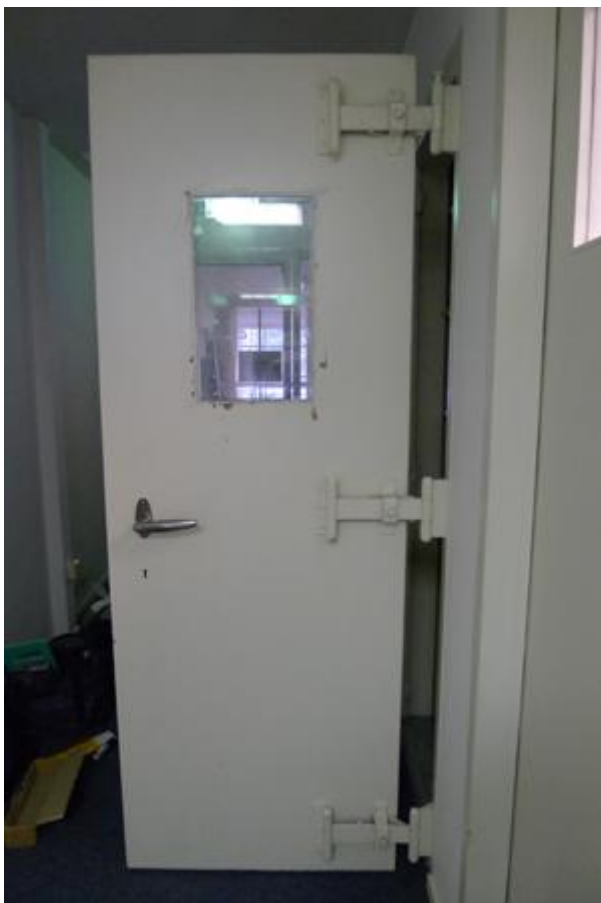
Hergebruikte/verplaatste stalen deur.
