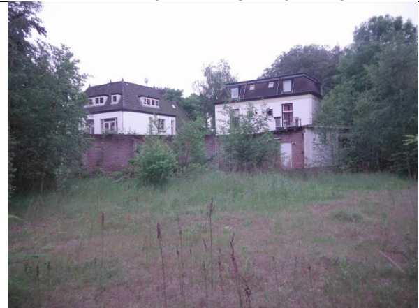
Vanuit noordoostelijke richting nabij boring 4
