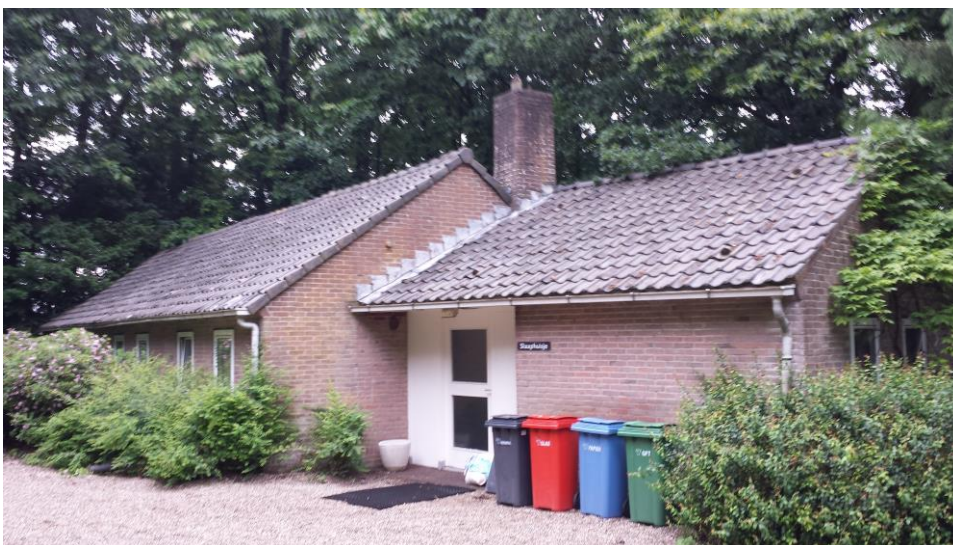
Afbeelding 5. Aan de kopse kanten van het slaaphuis is veel begroeiing aanwezig.
