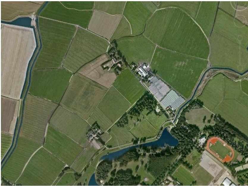
Figuur 7 luchtfoto: helft van de kassen reeds verdwenen
