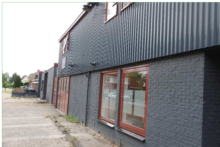
Zwart geverfde muren met metalen sandwichpanelen.
