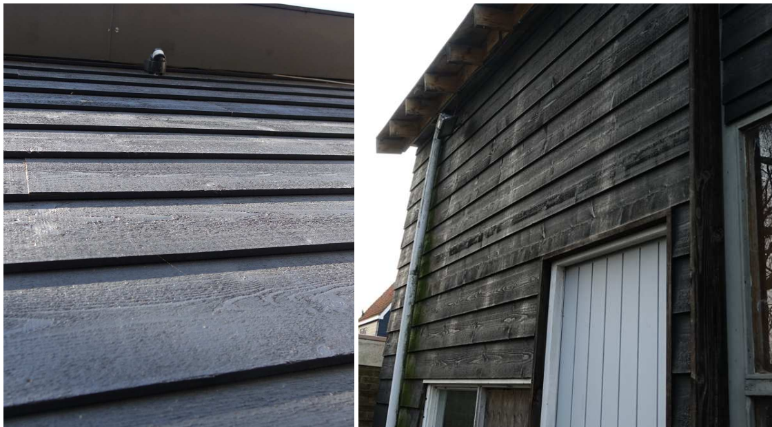
Figuur 5. Goed aansluitende houten delen aan de voorgevel plus bewegingscensor voor de waakverlichting met felle bouwlampen
