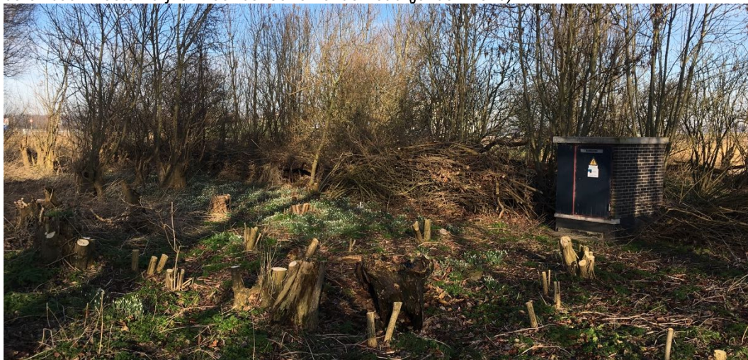
Een deel van het hakhoutbosje is afgezet in voorbereiding van het doen van gestuurde boringen die uitkomen en beginnen op het terreintje (februari 2019).
