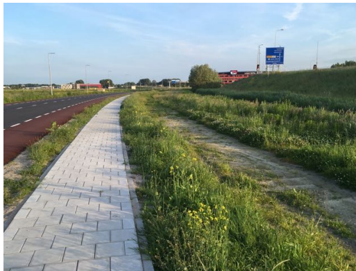
Voetpad in/naast de toekomstige ecozonestrook in de Etalage (zicht op het noorden) in mei.
