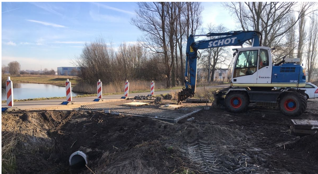
Bouw van een nieuwe dam, waarmee het terrein rond boerderij de Stal en het eiland van Poel 7 bereikbaar moeten blijven voor beheer en onderhoud (januari 2019).
