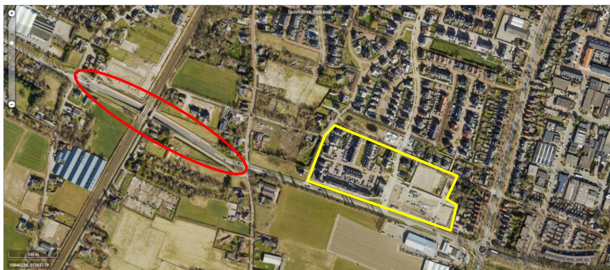
Figuur 1 Onderdoorgang spoor (rode contour) en nieuwbouw woningen (gele contour) (bron: cyclomedia luchtfoto 2022)
