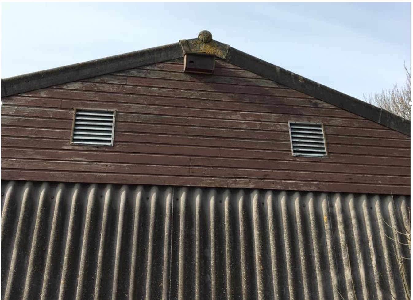
Figuur 4. Te slopen schuur met Gierzauwkast en houten bekleding topgevel.
