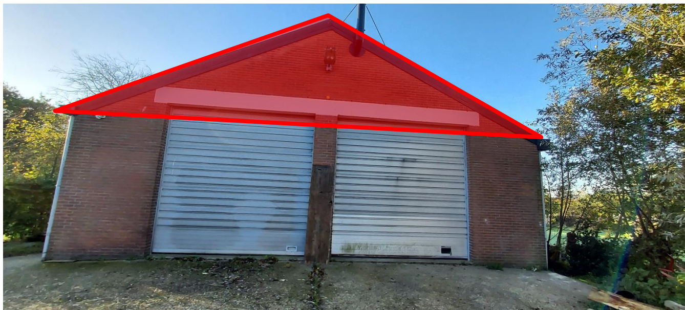
Figuur 21: Aanwezige dak met een hoek minder dan 45 graden.
