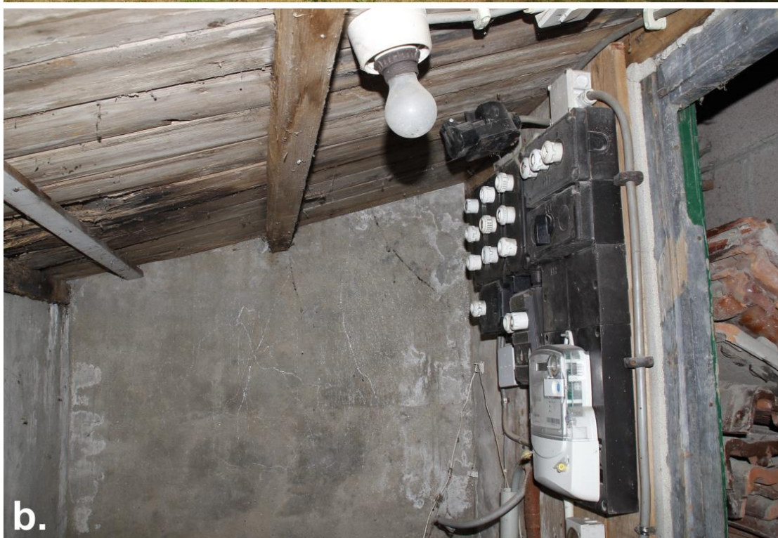
Figuur 9. Klein aanbouwsel bij de schuur (a; geel gehighlight) met een meterkast en een stapel dakpannen (b).
