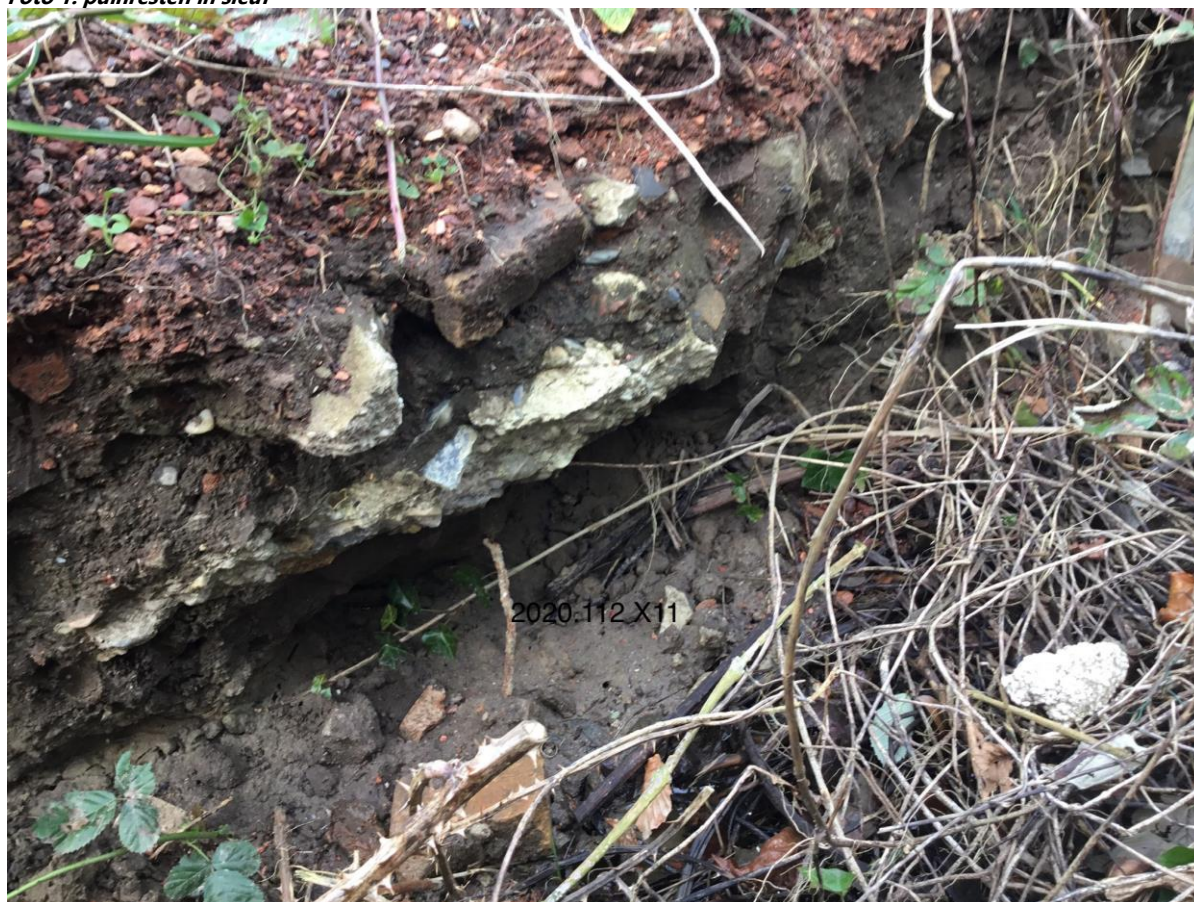
Foto 1: puinresten in sleuf
