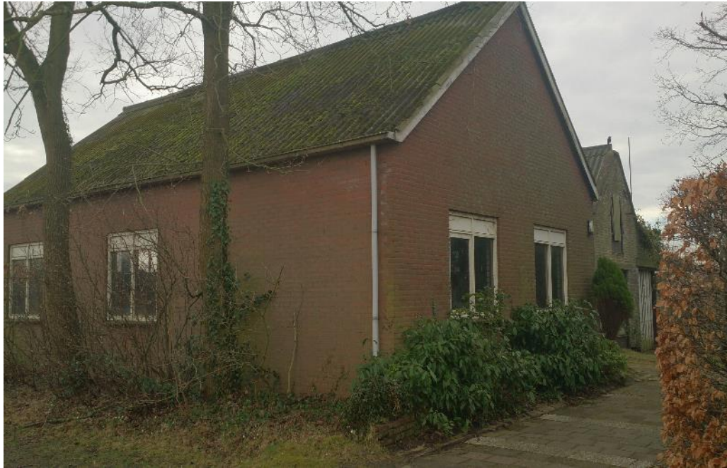
Figuur 1 De planlocatie betreft een woning en schuur aan de Krommelaan 6a te Heiloo. De woning is opgetrokken uit gemetselde muren en een golfplaten dak. Daarbij is ook nog een braakliggende kavel gesitueerd.
