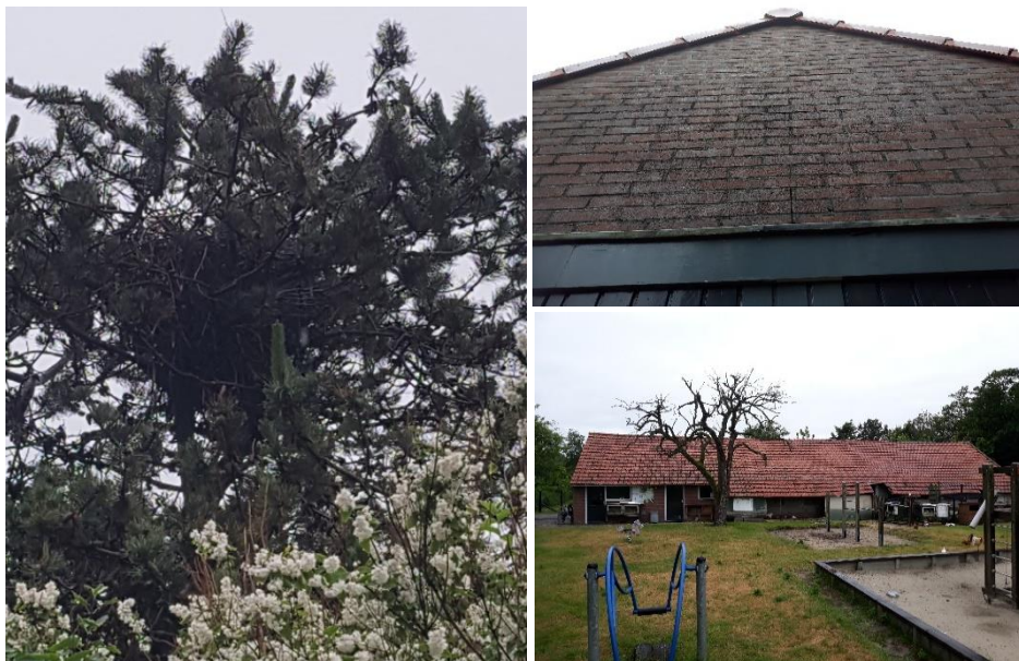
Links het roofvogelnest, rechts de schuur met geschikte invliegopening voor gierzwaluw en dakpannen voor huismus; (foto's Laneco).
