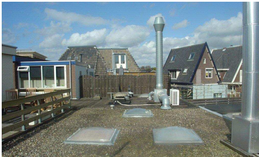
Afbeelding 11. Bestaande afvoerpijpen aan de achterzijde.
