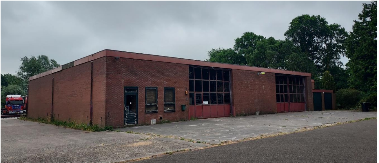
Figuur 11. Het te slopen pand
